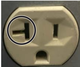
Toma de corriente de 20 A con clavija en forma de T
