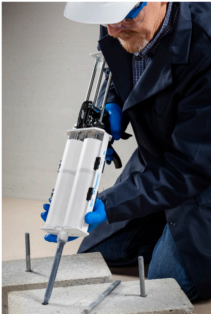
As pistolas portáteis ligeiras de dosificação manual 2K são ideais para ancoragens químicas.
