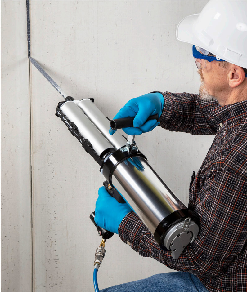
Leistungsfähige, pneumatische 2K-Dosierpistolen sind ideal für Rissinjektionsanwendungen geeignet.
