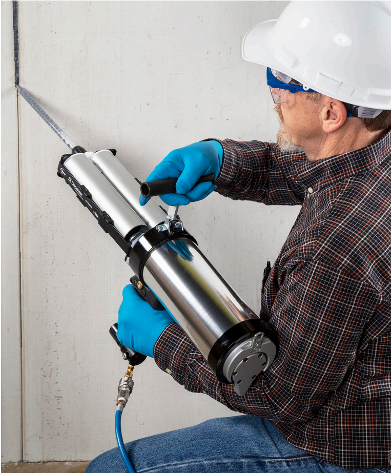
Las potentes pistolas dosificadoras neumáticas 2K son ideales para aplicaciones de inyección en grietas.
